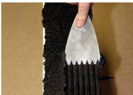
4. Työstö Enkolit® hammastetulla lastalla
