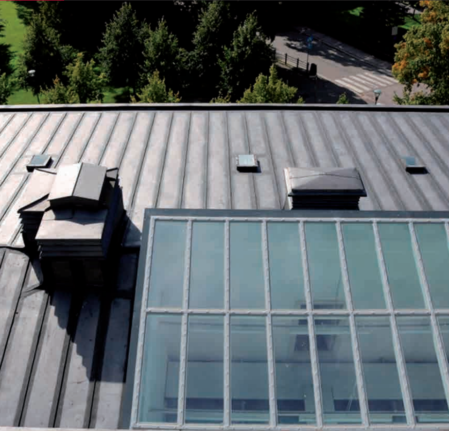
▲ Marmoripalatsin konesaumakaton saumat ja kattoikkunat tiivistettiin huolellisesti Enkopurilla.
