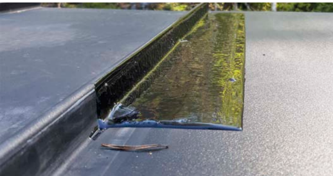
▲ Lumisteen irtoamisesta syntyneiden reikien tiivistys lukkosaumakatolla.
